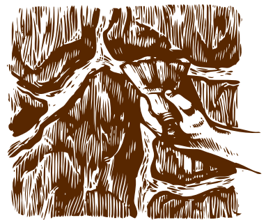
FIG. 9 Whisk away Loose Mortar
